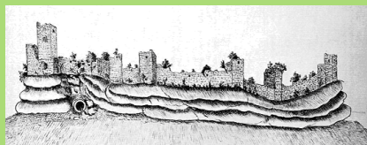
Château de Pierre Percée vers 1755
